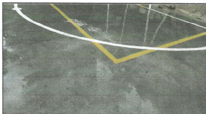
Foto 4: SUSTITUCIÓN LOSA DE PATIO
