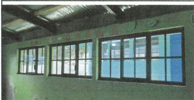
Foto 1: SUSTITUCIÓN DE ESTRUCTURA DE METAL MAS VIDRIOS EN AULAS
