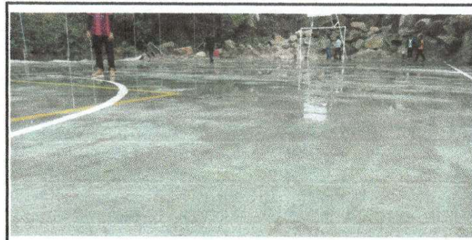
Foto 6: SUSTITUCION LOSA DE PATIO
