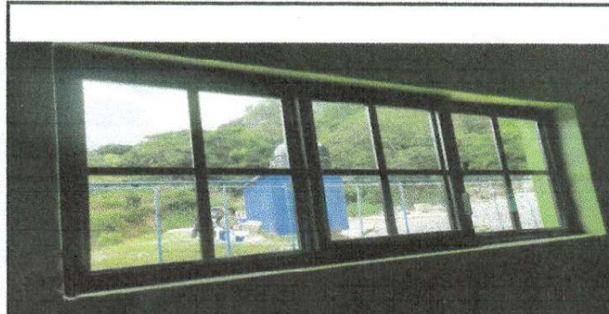
Foto 2: SUSTITUCIÓN ESTRUCTURA DE METAL MAS VIDRIO EN AULAS MODULO 1
